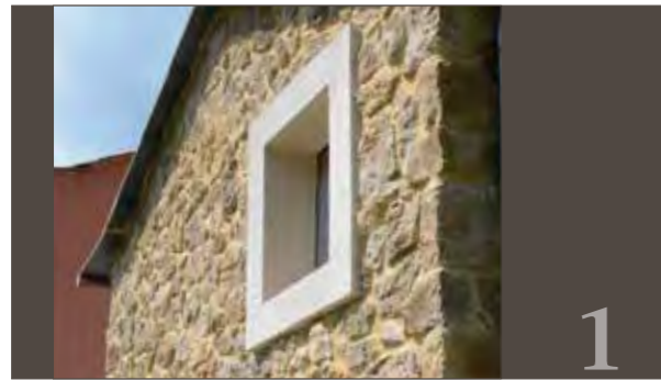
contour de fenêtre avec tableaux ragréé et coloré
