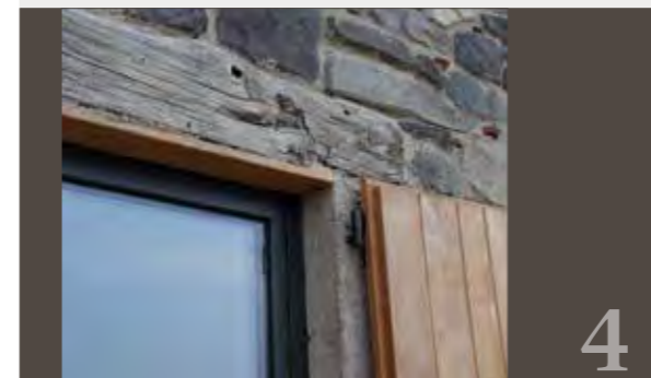
linteau de fenêtre avec poutre en bois
