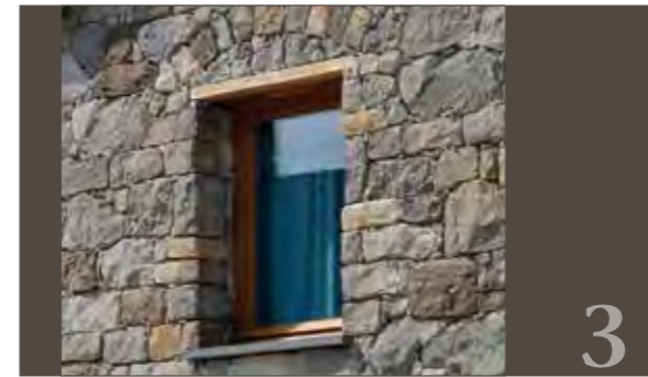
linteau de fenêtre avec planche de soutien
