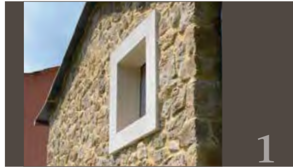
contorno finestra con cornice rasata e colorata
