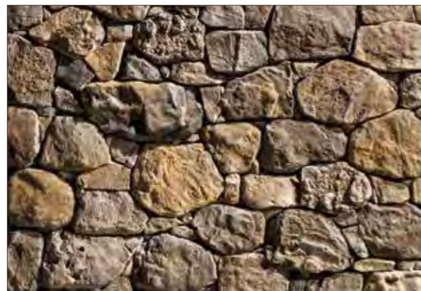
fuga a secco
