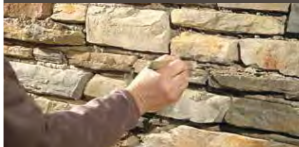
Ingesneden voeg realiseren
