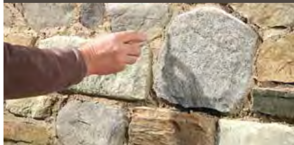
Uitkrabben met een houten stokje
