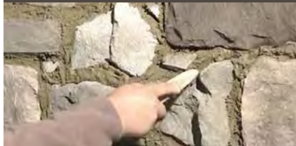
Ingesneden voeg realiseren
