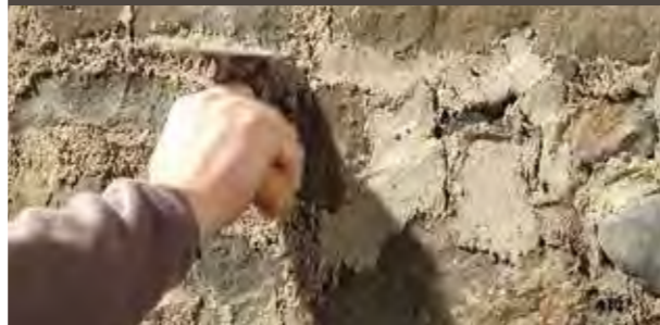
Afwerken met een platte spaan
